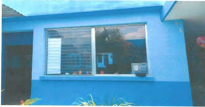
Foto 3: Se instalaran balcones de hierro en ventanas para poder tener mejor seguridad en cada aula.
