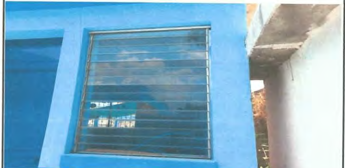
Foto 2: Se instalaran balcones de hierro en ventanas para poder tener mejor seguridad en cada aula.
