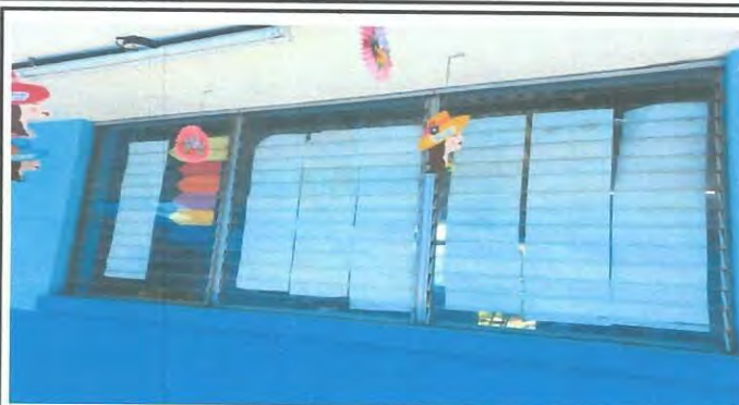
Foto 2: Se instalaran balcones de hierro en ventanas para poder tener mejor seguridad en cada aula.
