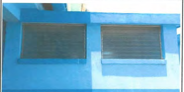
Foto 4: Se instalaran balcones de hierro en ventanas de los sanitarios para mayor seguridad.
