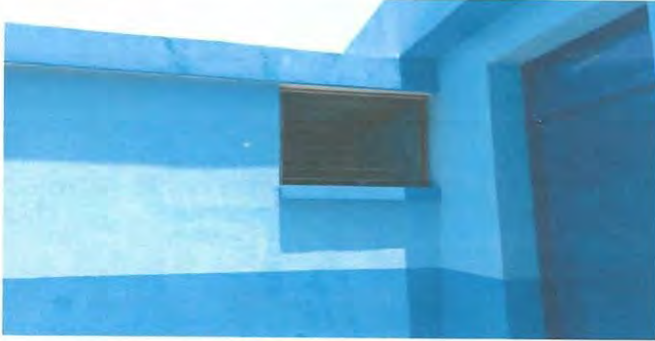
Foto1: Se instalaran balcones de hierro en ventanas de los sanitarios para mayor seguridad.
