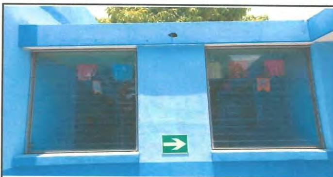
Foto 4: Se instalaran balcones de hierro en ventanas para poder tener mejor seguridad en cada aula.
