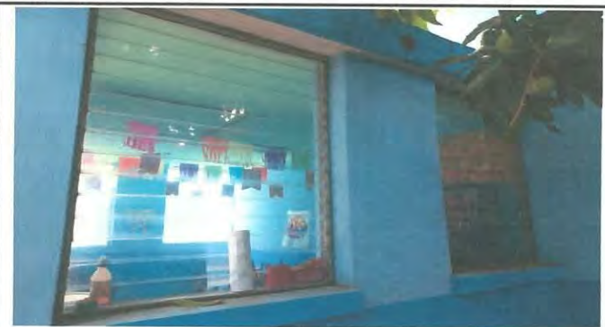
Foto 3: Se instalaran balcones de hierro en ventanas para poder tener mejor seguridad en cada aula.
