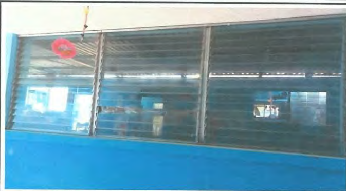
Foto1: Se instalaran balcones de hierro en ventanas para poder tener mejor seguridad en cada aula.
